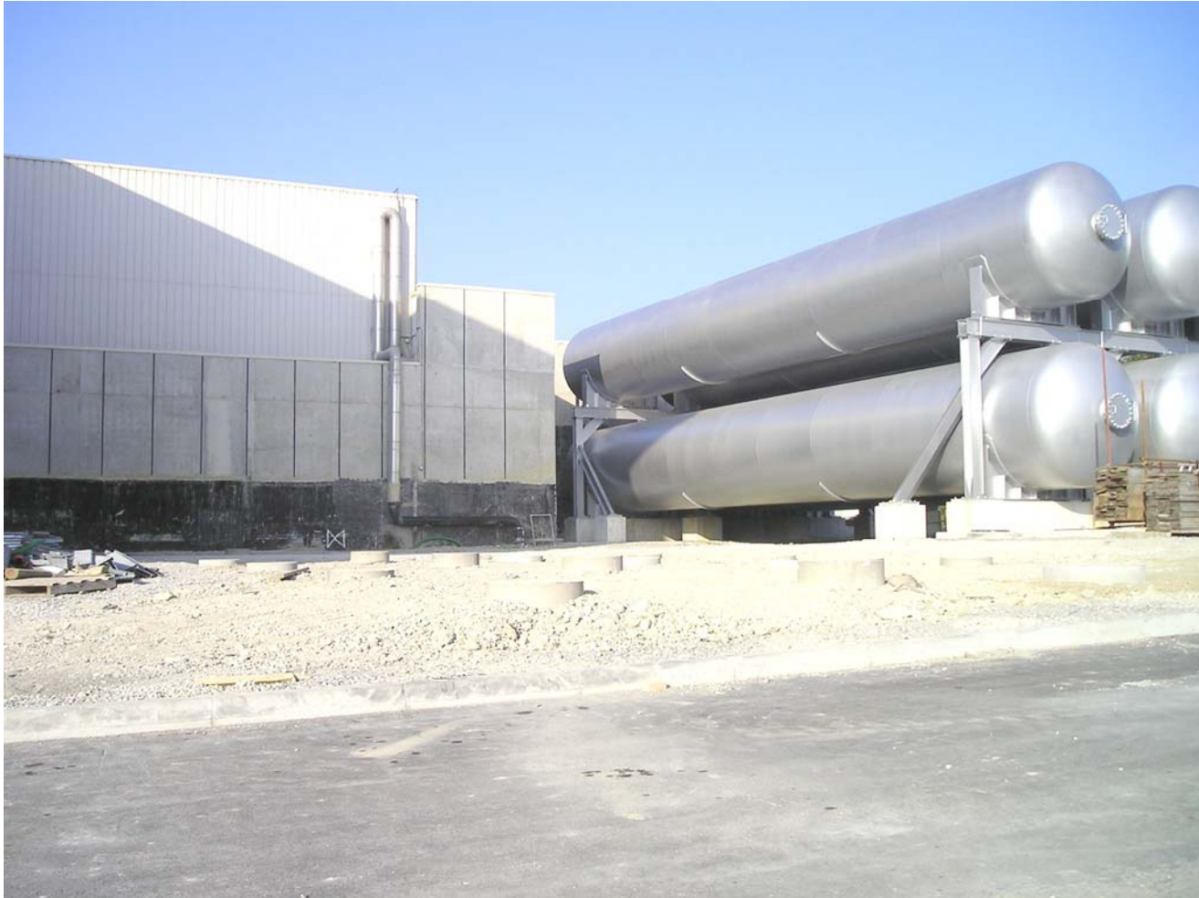
Plots en béton pour les baraques à côté des reservoirs helium au Point 1
